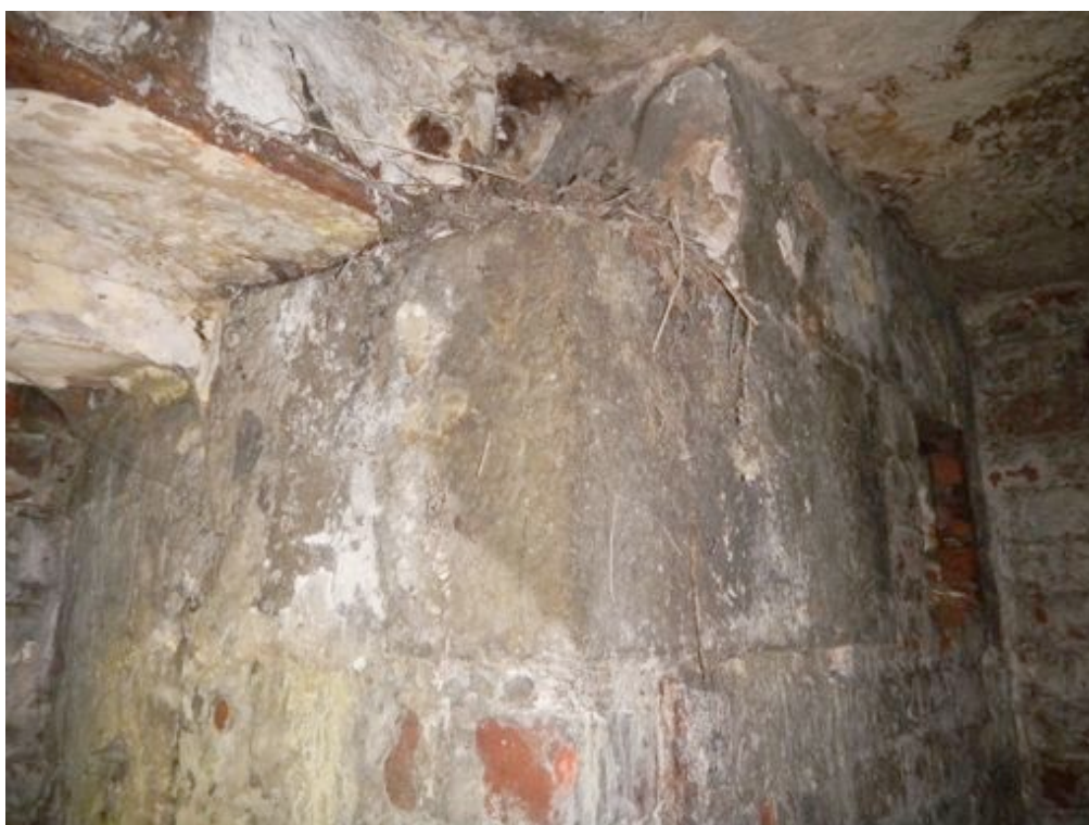
Fot. 52. Blok granitowy podtrzymujący nadproże stalowe.
