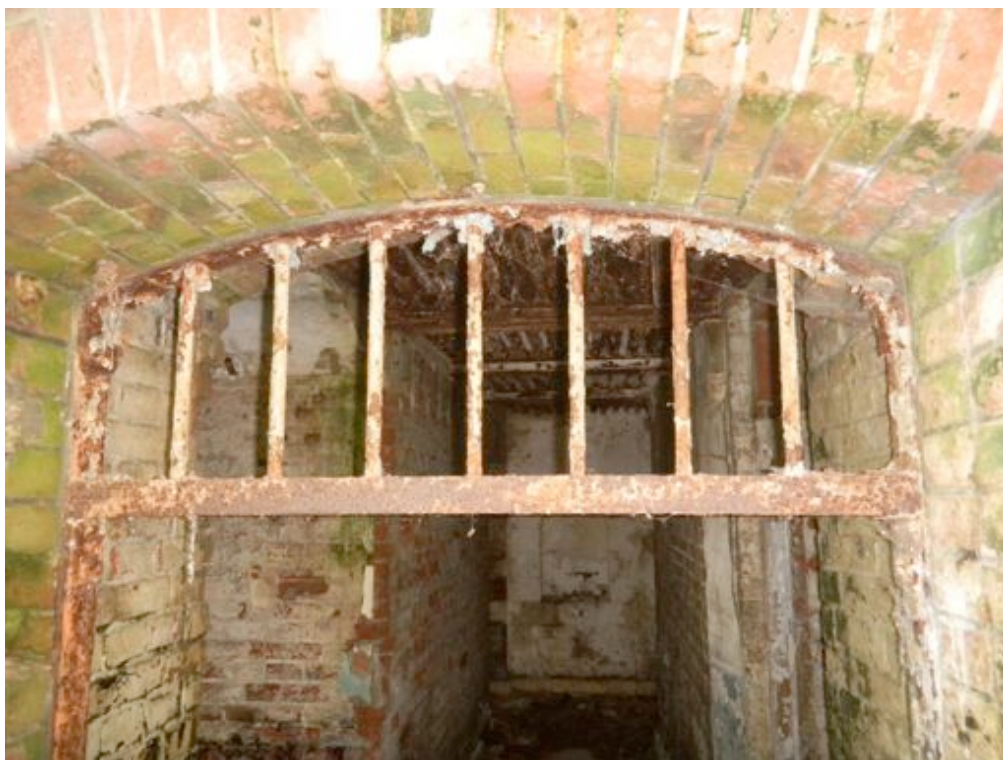
Fot. 33. Stalowa krata nad wejściem – pozostałość stalowych drzwi wejściowych.
