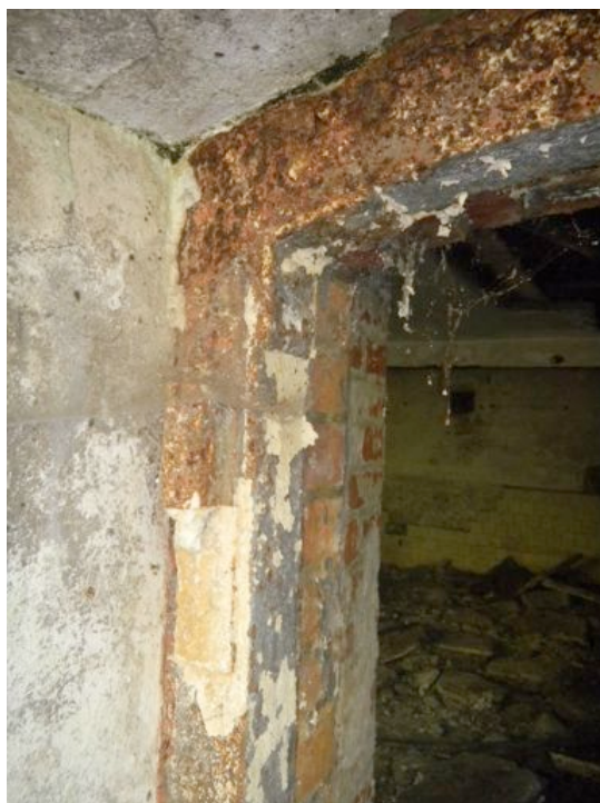
Fot. 30. Stalowa rama – pozostałość pierwotnych okiennic, widoczna znaczna korozja stali oraz wtórne przemalowania.
