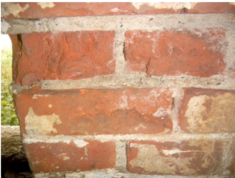
Fot. 40. Pierwotna zaprawa wapienno-cementowa, którą użyto do murowania.
