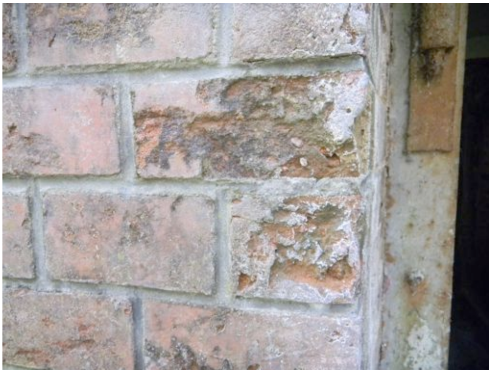
Fot. 47. Rozwarstwienia lica ceglanego, białe naloty z soli rozpuszczalnych w wodzie.
