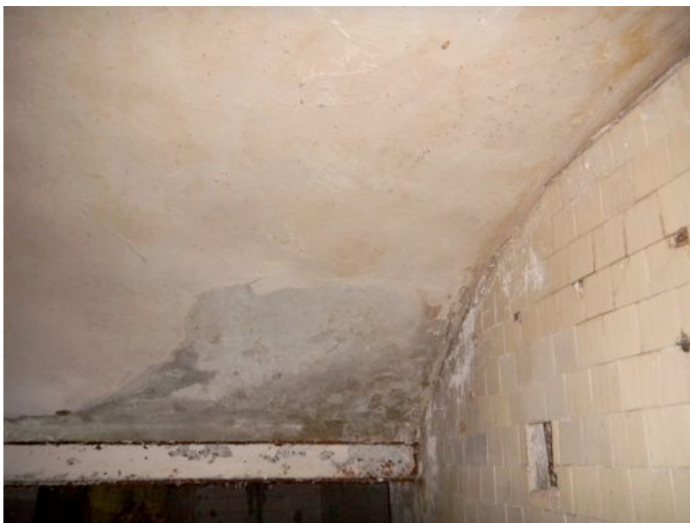
Fot. 38. Betonowe sklepienie, pokryte warstwami farb dyspersyjnych.
