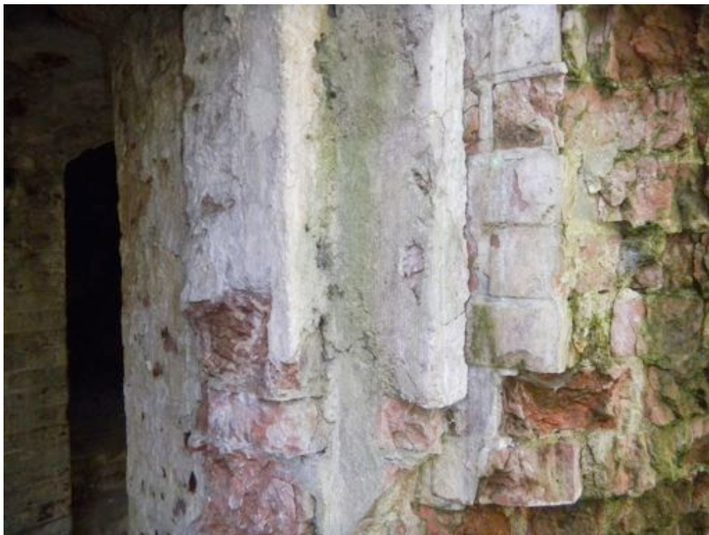
Fot. 11. Wtórne tynki w ościeżach okiennych – widoczna destrukcja lica ceglanego oraz znaczny rozwój drobnoustrojów.
