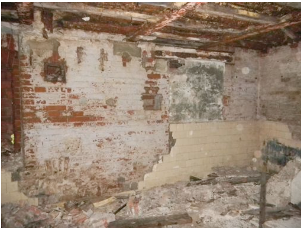
Fot. 29. Stan zachowania pomieszczeń na parterze – duże ubytki w murze ceglanym, całkowita destrukcja stalowej konstrukcji stropów.
