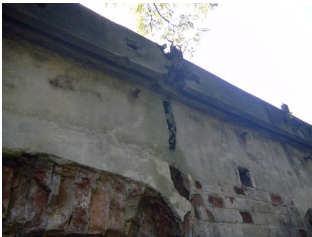
Fot. 10. Spękania wtórnego tynku cementowego pokrywającego nadproża ceglane, widoczna korozja stali pozostałości uchwytów balustrady.
