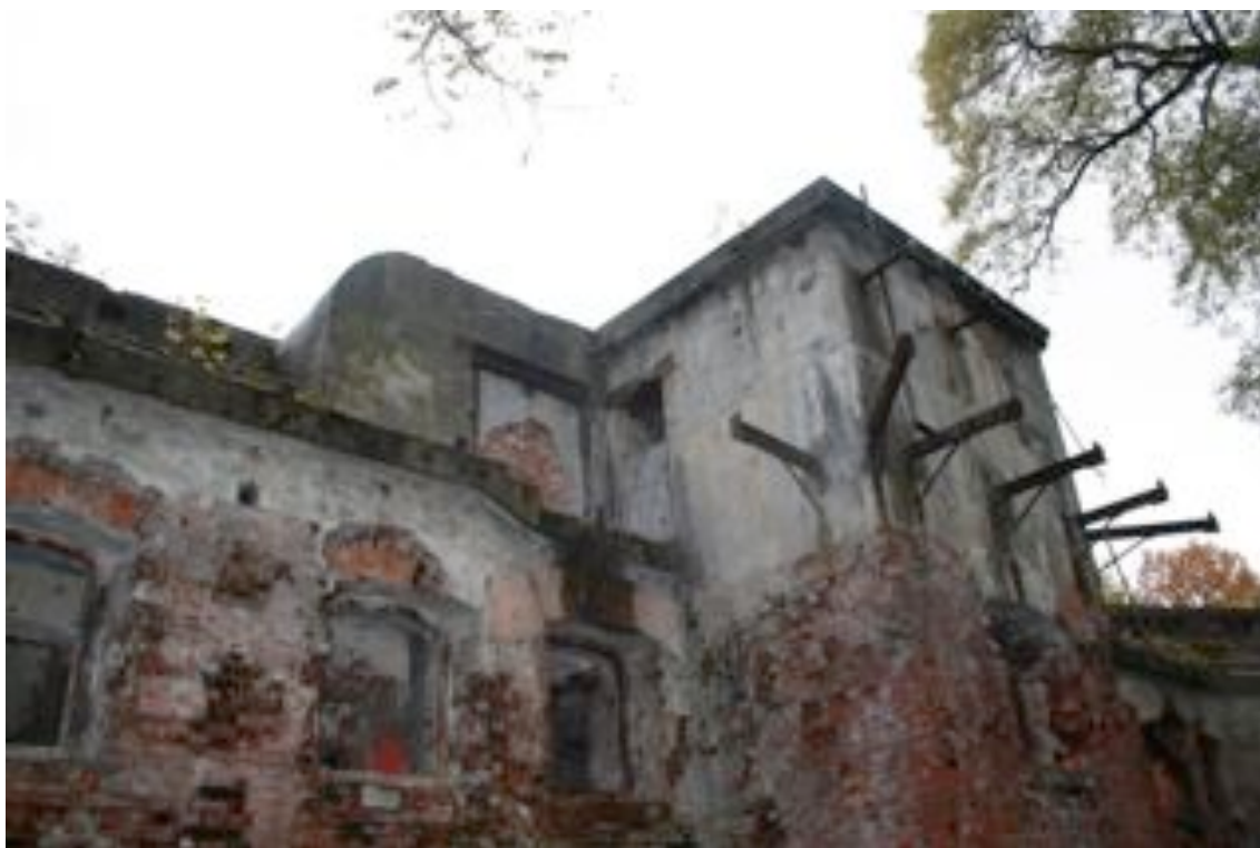
Fot. 4. Wieża – widoczne pozostałości stalowej konstrukcji galerii wokół wieży.
