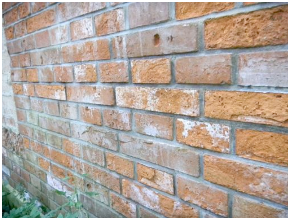
Fot. 21. Wykwity soli rozpuszczalnych w wodzie z cementu, który użyto do spoinowania ściany – widoczne rozwarstwienia powierzchni cegieł.
