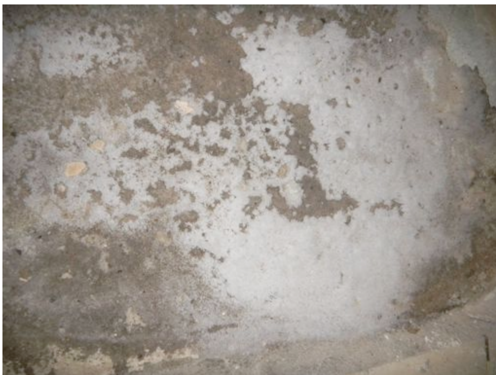
Fot. 28. Wykwity soli rozpuszczalnych w wodzie na tynkach ścian wewnętrznych.
