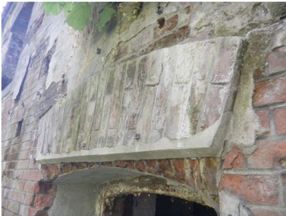
Fot. 65. Wykruszenia cegieł nadproża łukowego naprawiane twardymi zaprawami cementowymi.
