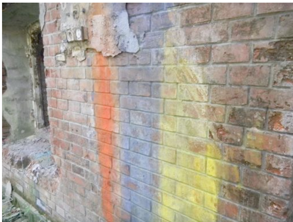
Fot. 46. Wtórne szlichty cementowe i powłoki malarskie na wątku ceglanym.
