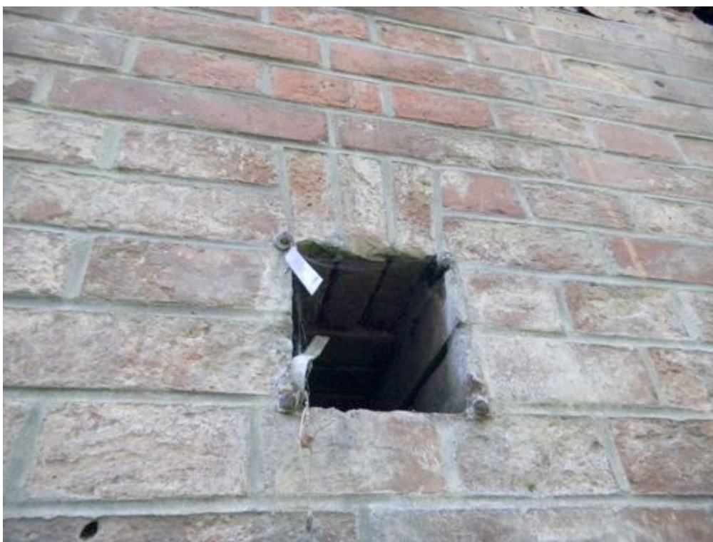
Fot. 42. Lico ceglane wtórnie spoinowane zaprawą cementową, białe naloty soli pochodzących z cementu.
