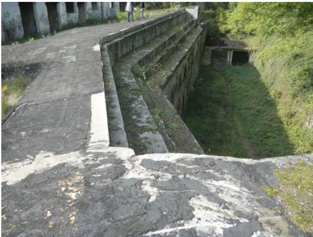
Fot. 67. Betonowy dach fortu pokryty wtórną papą niskiej jakości.
