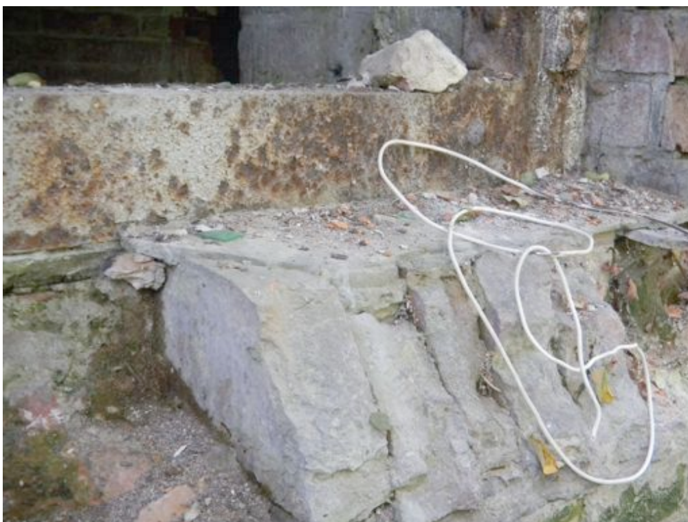
Fot. 62. Wykruszenia cegieł podokiennika zewnętrznego, widoczna spękana wylewka cementowa.
