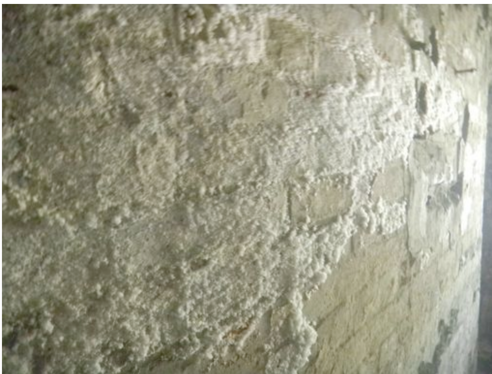
Fot. 54. Wykwity soli rozpuszczalnych w wodzie na ścianach wewnętrznych.
