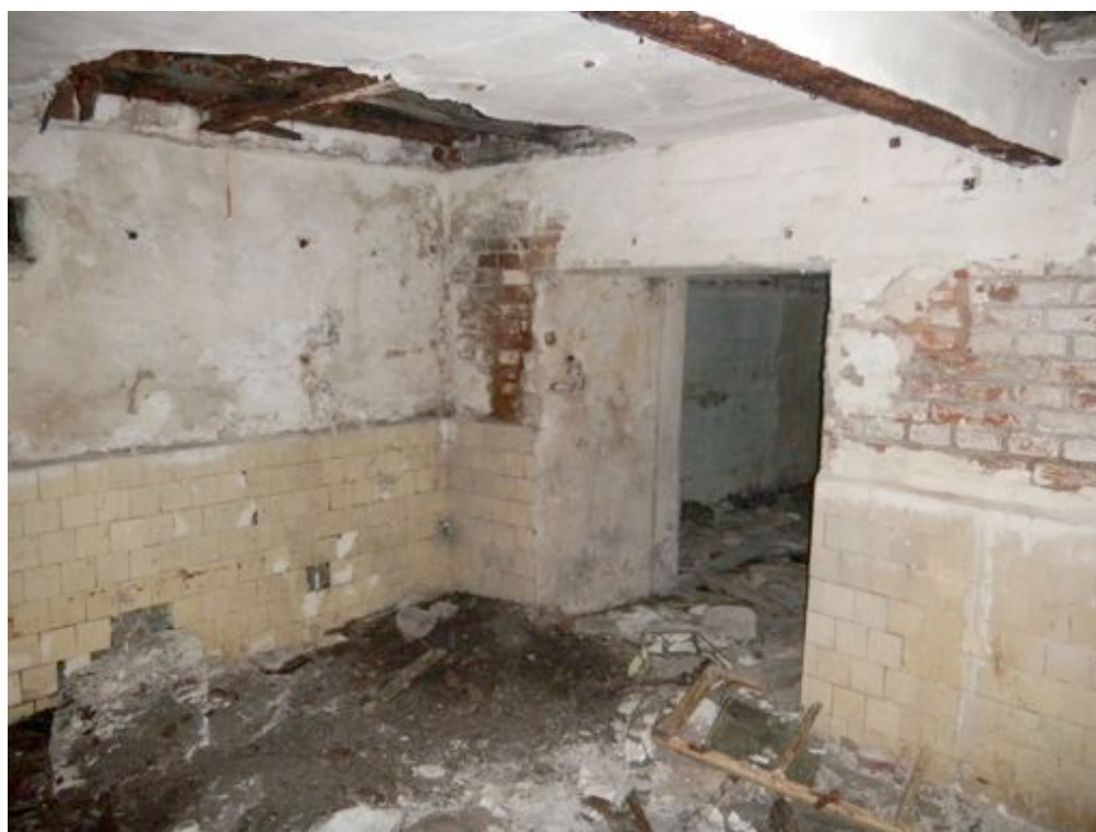
Fot. 24. Pomieszczenie na parterze – widoczne wtórne tynki i płytki ceramiczne, znaczne zawilgocenie narożnika ściany.
