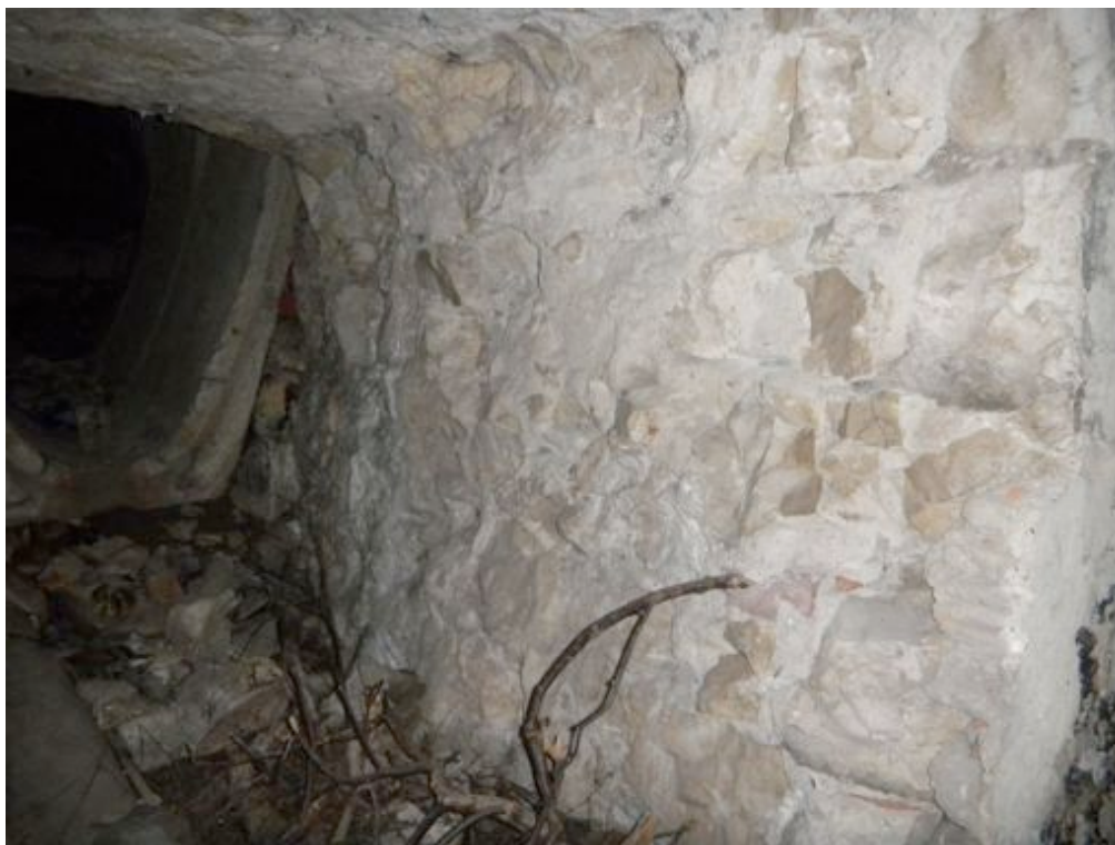
Fot. 55. Przekrój ściany z bloków kamiennych od strony nasypu ziemnego.
