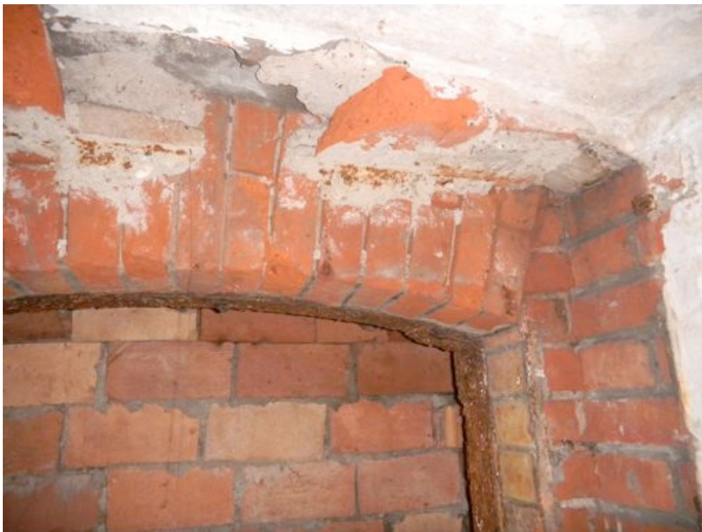
Fot. 39. Ubytki w wątku ceglanym nadproża i glifu okiennego od strony wewnętrznej.
