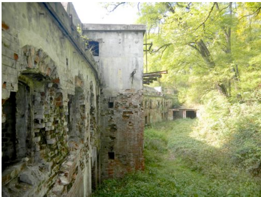
Fot. 57. Widoczna destrukcja filara międzyokiennego, który utracił ok. 1/3 swej grubości.
