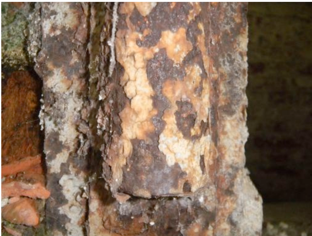
Fot. 63. Wtórne przemalowania zawiasu w ramie stalowej okiennicy.
