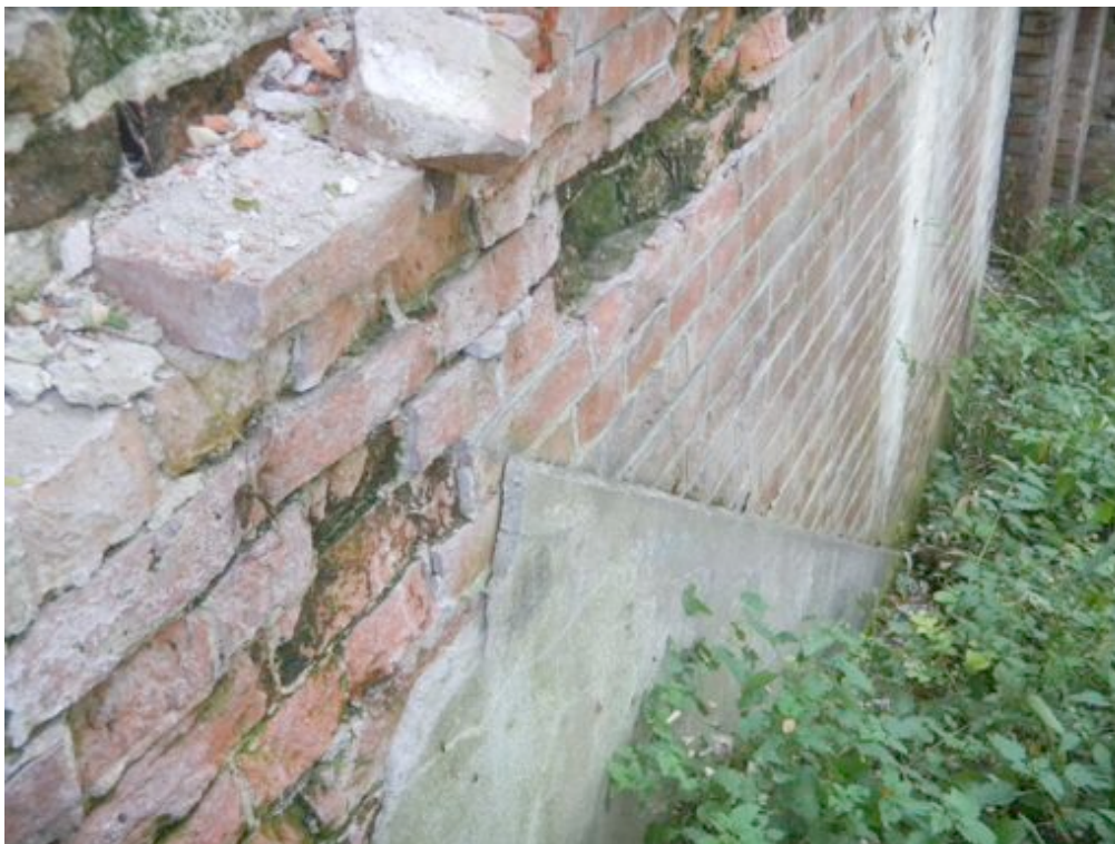
Fot. 61. Wtórne tynki cementowe w partii cokołowej, odpojenia cegieł.
