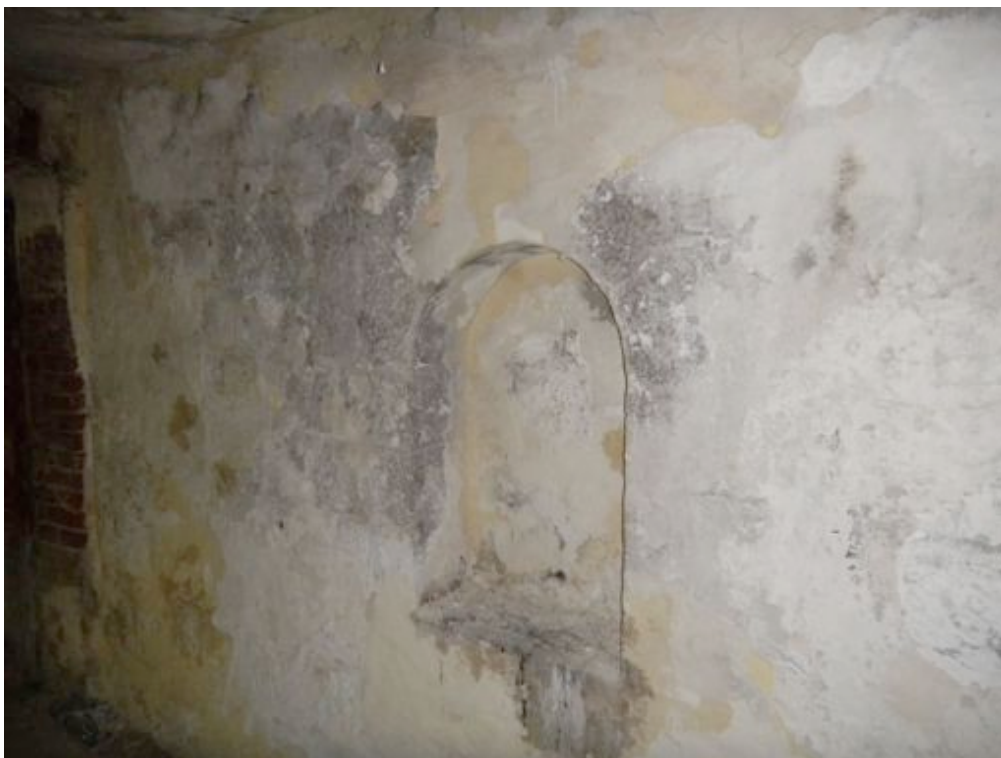
Fot. 50. Kamienna ściana pokryta warstwami farb – widoczne zawilgocenie ściany na całej wysokości.
