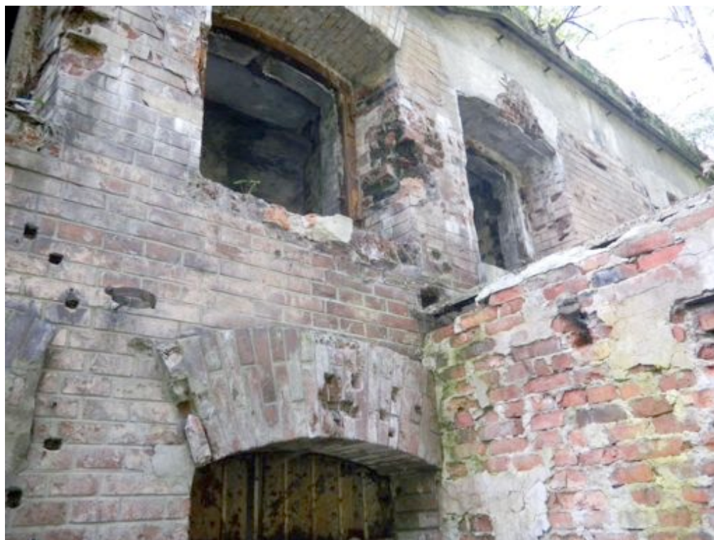
Fot. 45. Wtórne tynki nadproża na piętrze, wtórna przybudówka zmieniająca artykulację architektoniczną elewacji.
