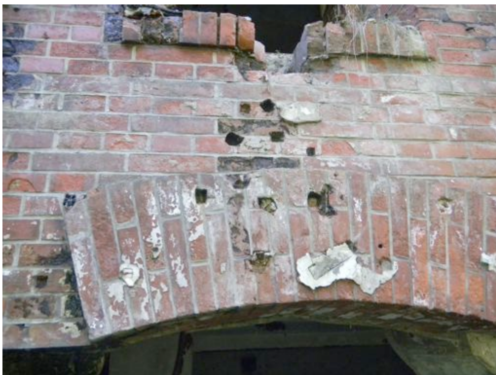
Fot. 12. Znaczne ubytki rolki ceglanej podokiennika, wtórne nawarstwienia.
