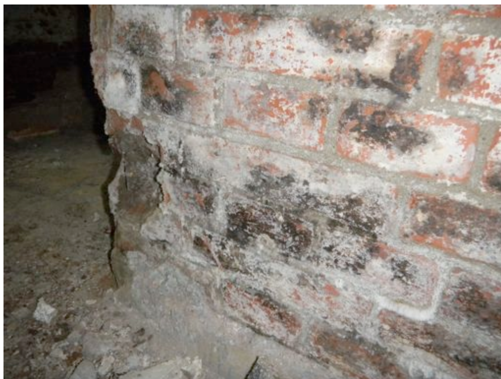
Fot. 36. Czarne nawarstwienia w partii przyziemia ścian wewnętrznych.
