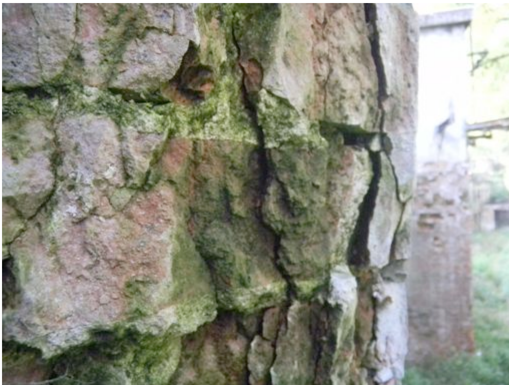
Fot. 59. Podłużne rozwarstwienia wątku ceglanego, porośnięte drobnoustrojami.
