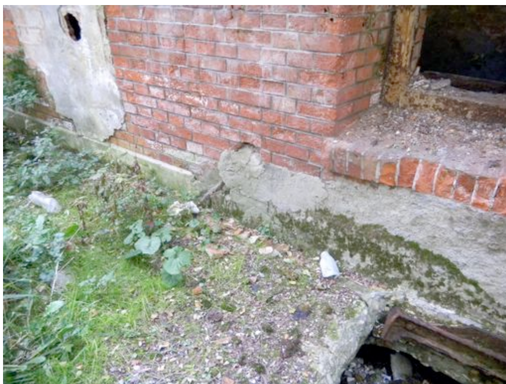
Fot. 20. Wtórne tynki cementowe w strefie przyziemia.
