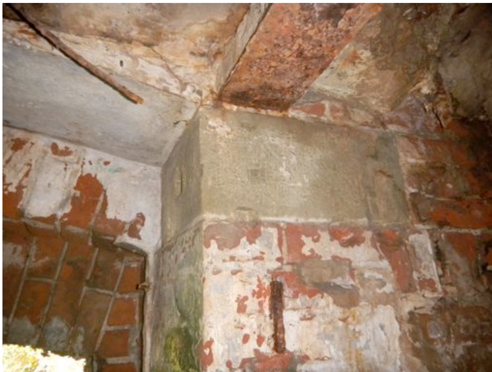
Fot. 41. Zachowane bloki granitowe, podtrzymujące belki stalowe stropu.
