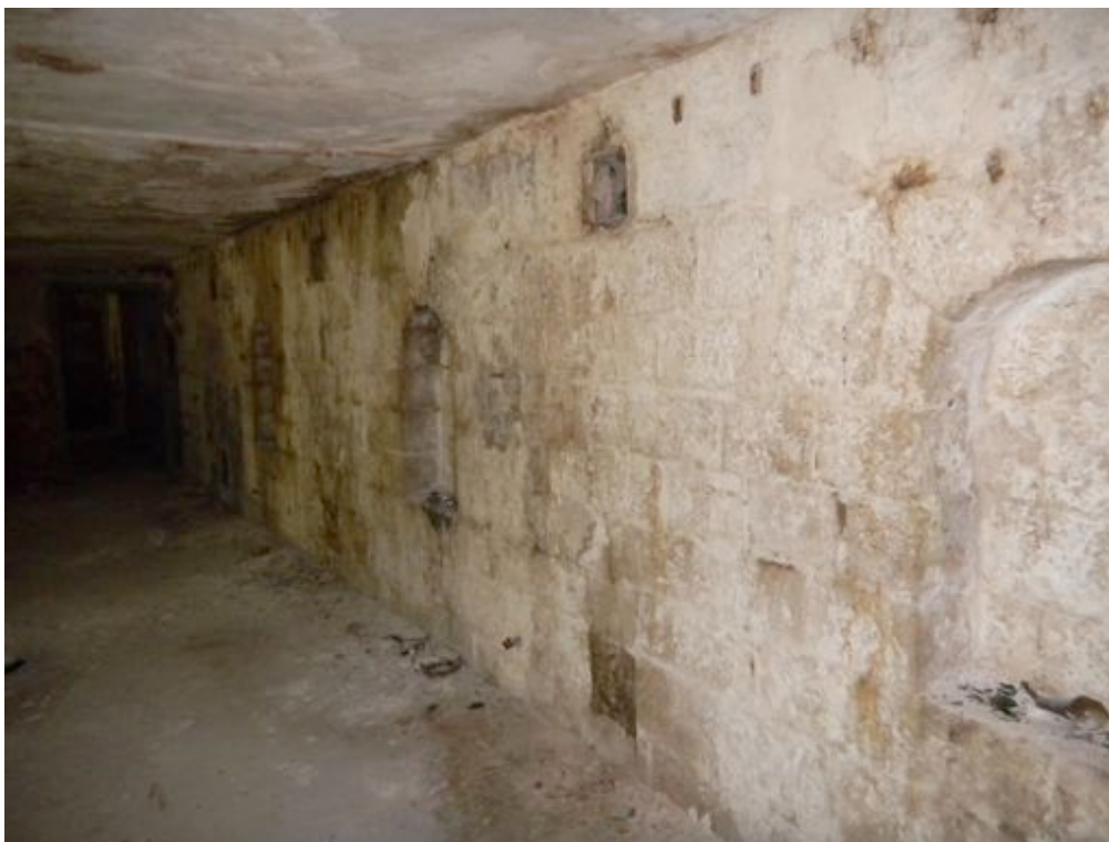
Fot. 53. Kamienna ściana – widoczne znaczne zawilgocenie i rozwój mikroorganizmów. Widoczny wątek bloków kamiennych.
