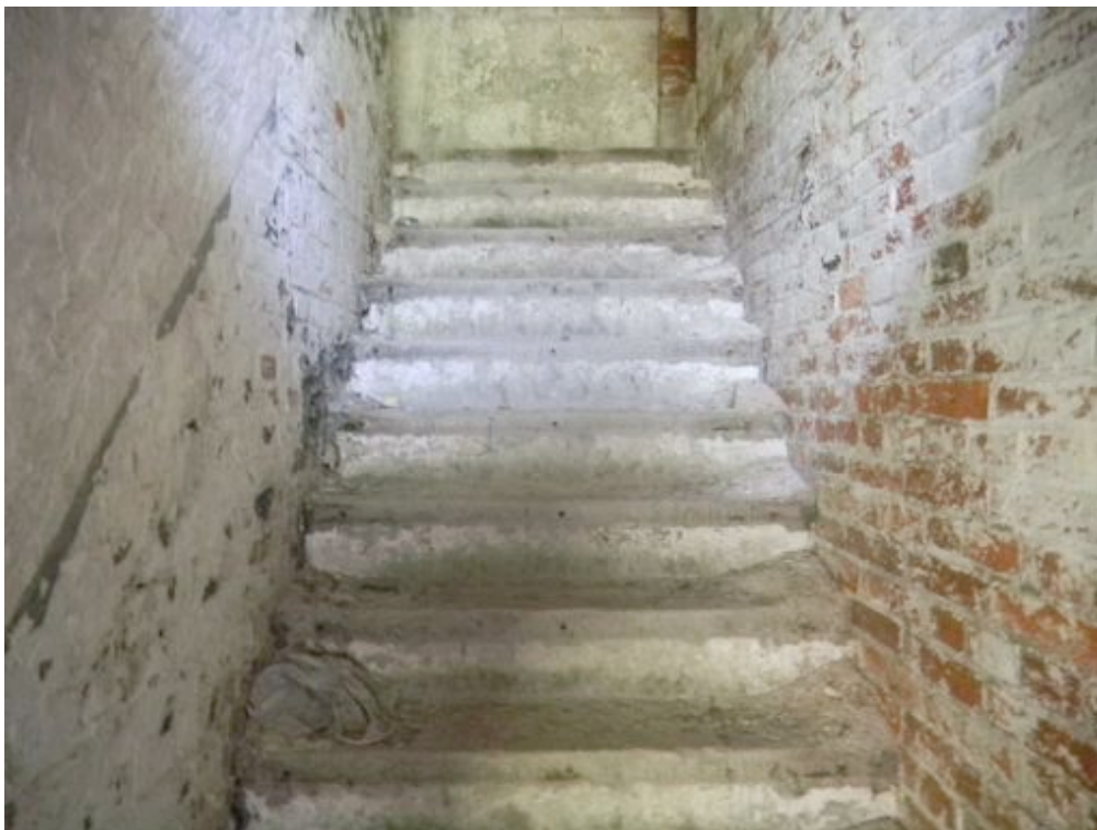
Fot. 49. Stan zachowania betonowych schodów wewnętrznych.
