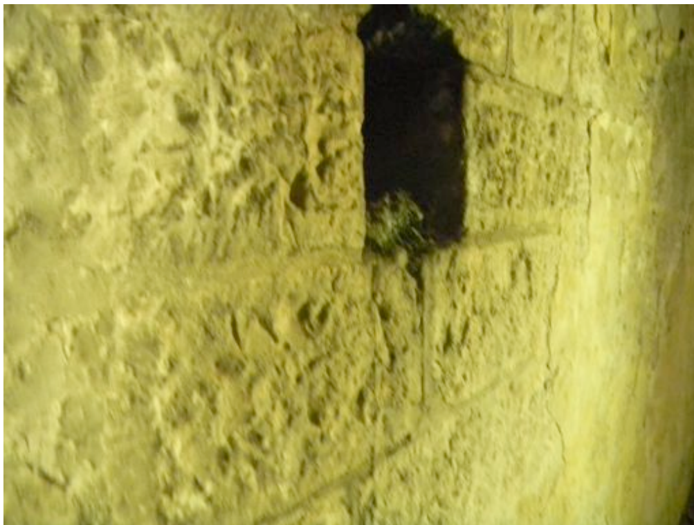
Fot. 51. Oryginalna faktura bloków kamiennych wykonana techniką ciosania.
