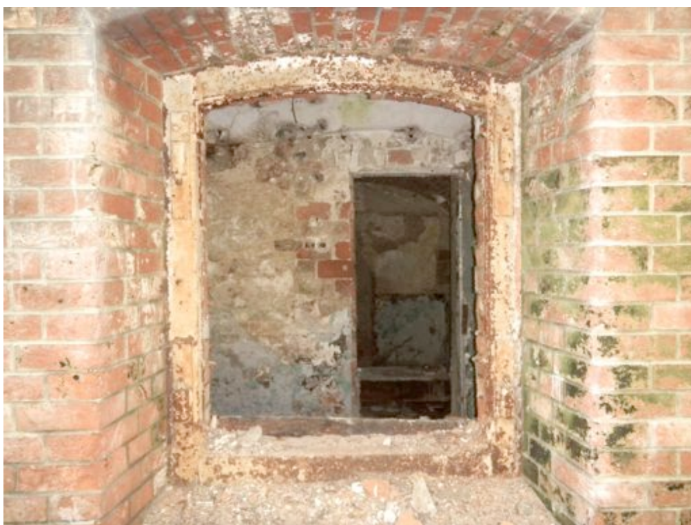
Fot. 32. Stalowa rama – pozostałość pierwotnych okiennic, widoczna znaczna korozja stali oraz wtórne przemalowania.
