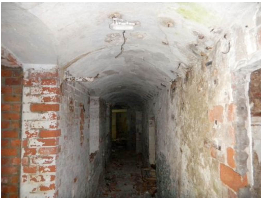
Fot. 34. Korytarz parteru – widoczne przemalowania farbami, wtórne zamurowanie otworu bloczkami.
