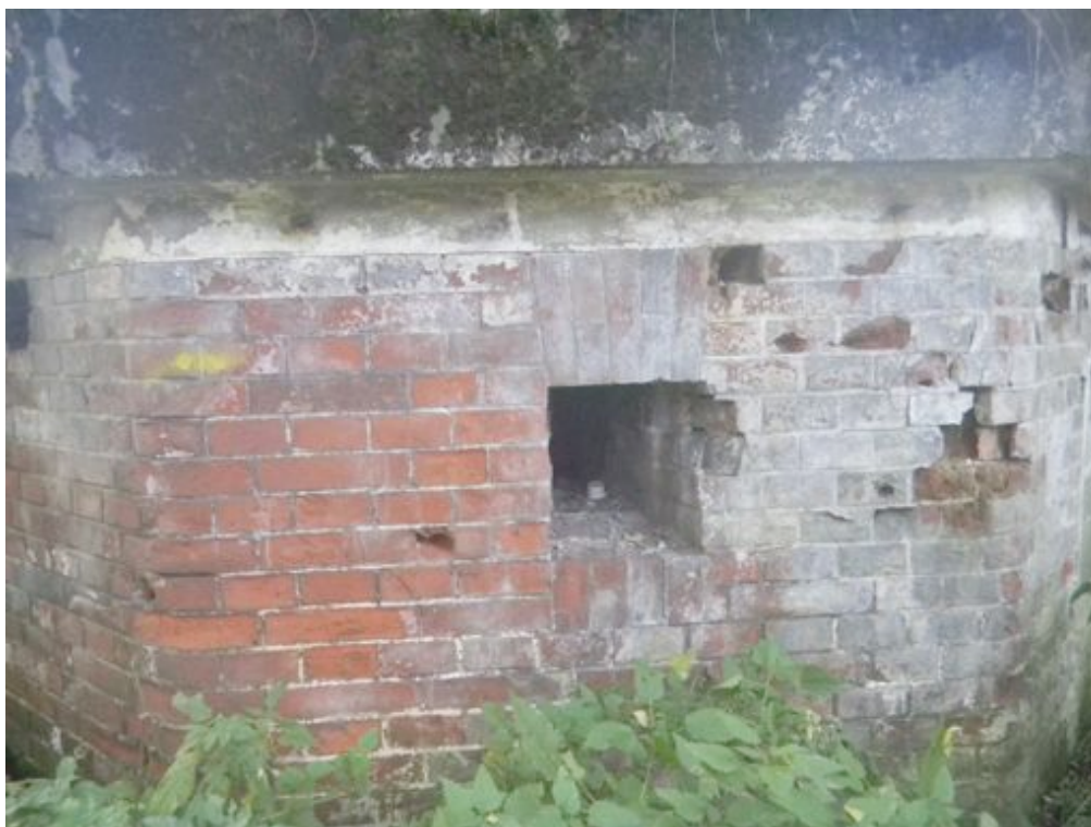
Fot. 70. Rozwarstwienia i ubytki cegieł w wątku ceglany.
