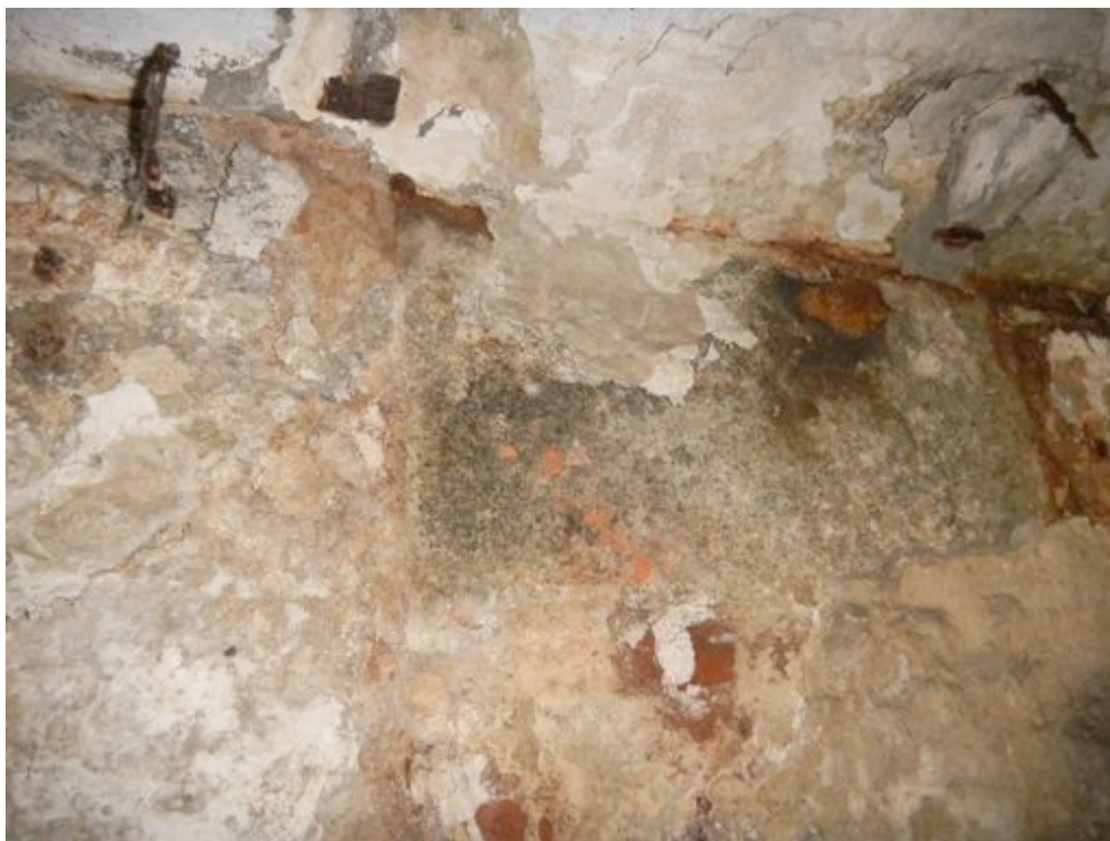
Fot. 37. Zachowane bloki granitowe, podtrzymujące belki stalowe stropu.
