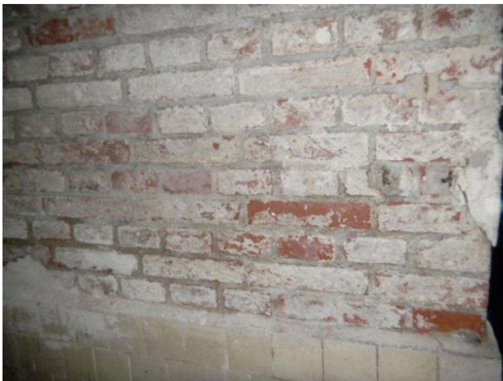
Fot. 26. Wewnętrzna ściana ceglana pokryta powłokami wapiennymi.
