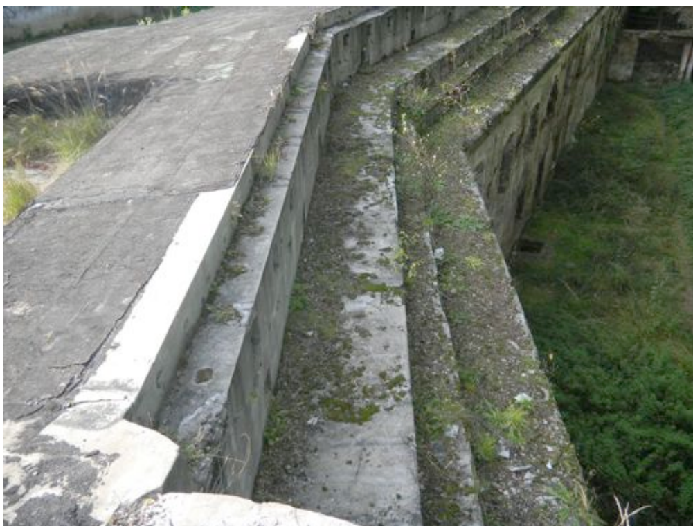
Fot. 68. Galeria betonowa –widoczne liczne spękania i wykruszona betonu, rozwój roślinności.
