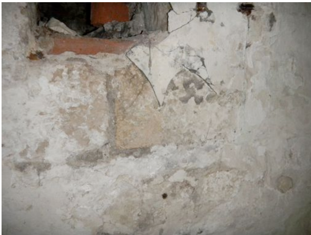
Fot. 25. Wewnętrzna ściana z bloków kamiennych, pokryta tynkiem cementowym oraz wieloma warstwami powłok malarskich.
