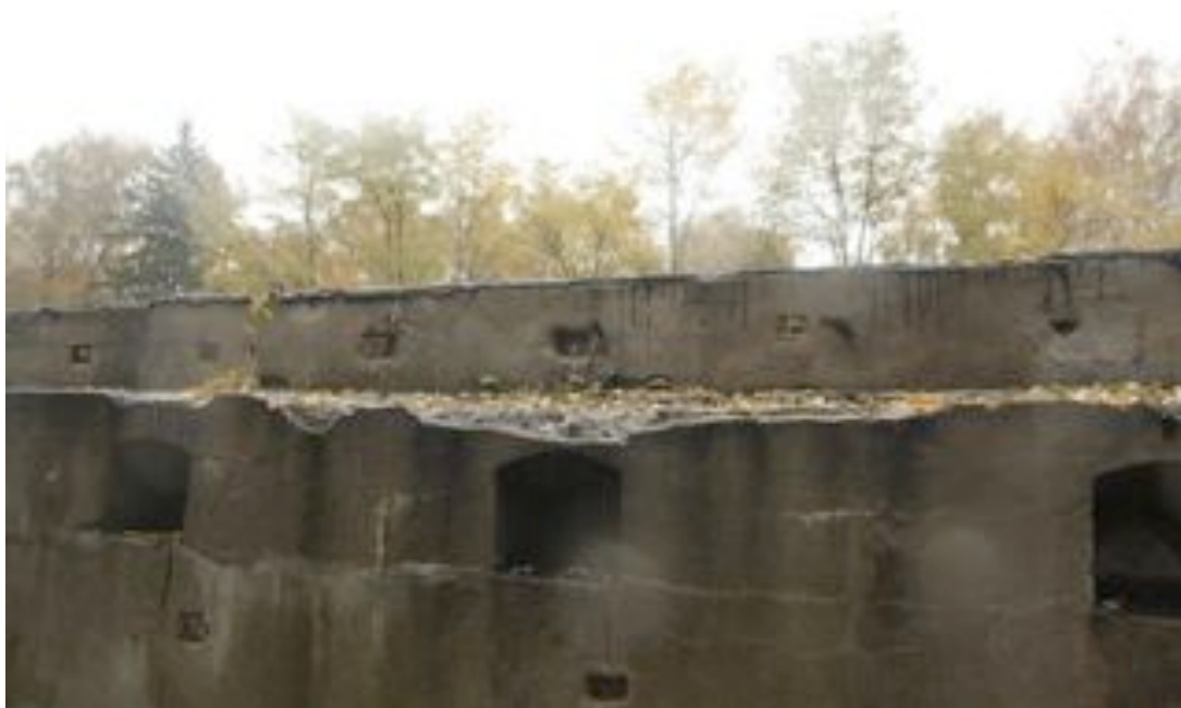
Fot. 7. Spękania i odspojenia betonowej galerii strzelniczej.
