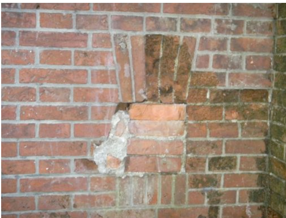
Fot. 14. Wtórne, nieestetyczne przemurowanie otworu okiennego.
