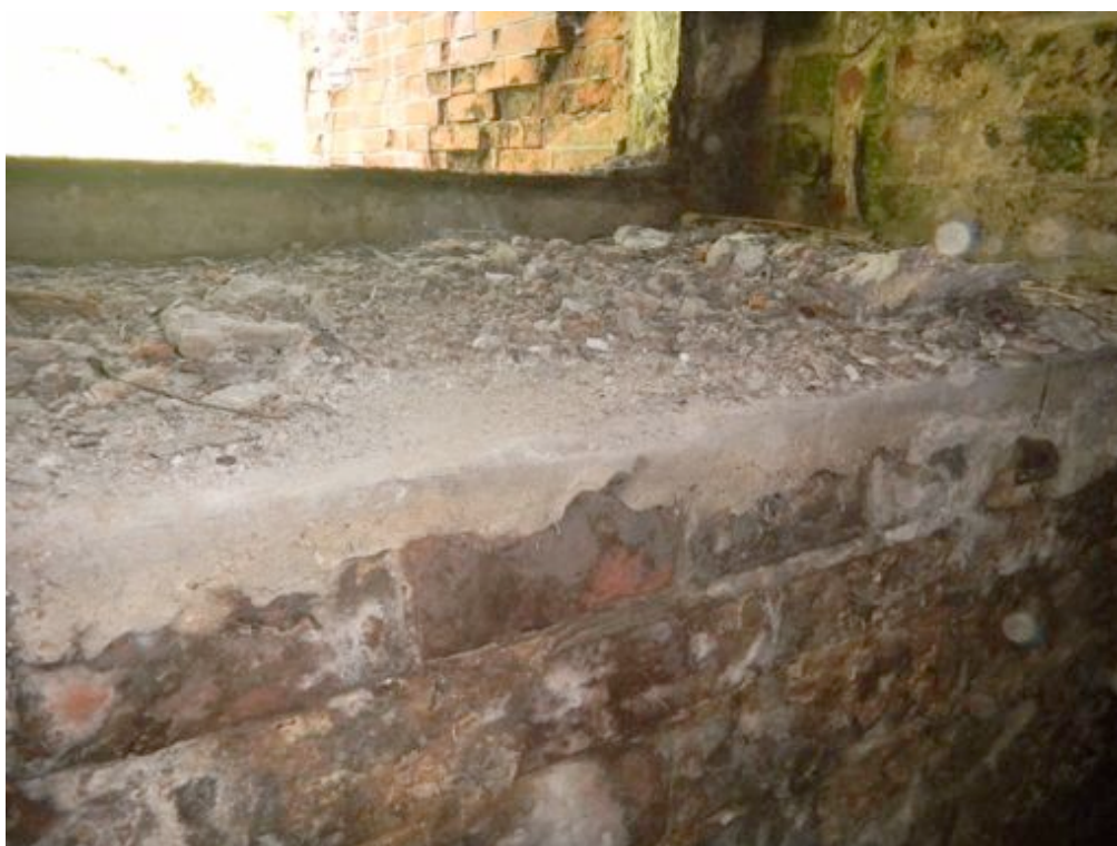
Fot. 56. Wtórne wylweki betonowe na parapetach okiennych.
