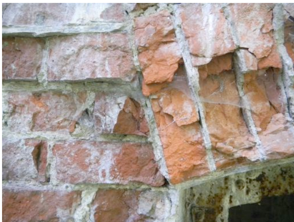
Fot. 60. Złuszczenia i ubytki wątku ceglanego.
