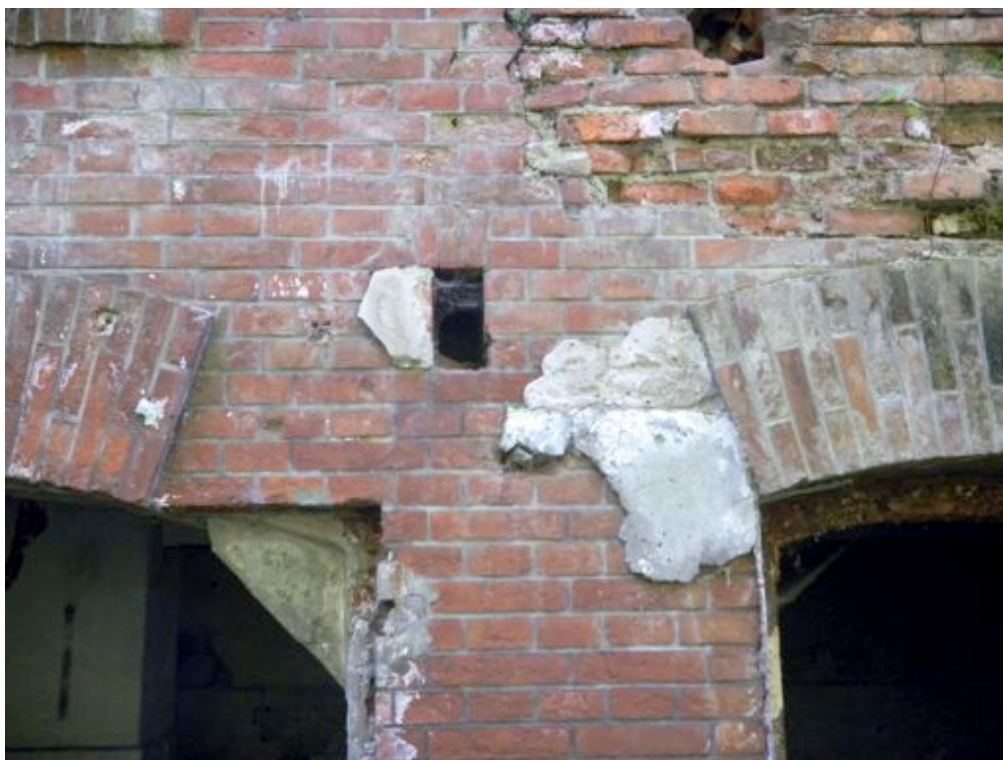
Fot. 17. Wtórne łąty betonowe, widoczne białe naloty na powierzchni cegieł.
