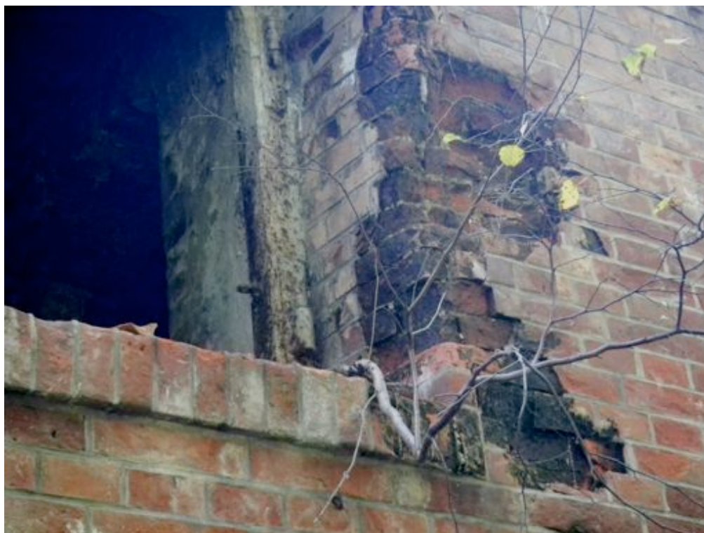
Fot. 19. Złuszczenia lica ceglanego, spowodowane przenikaniem wód opadowych i zjawiskami mrozowymi oraz zastosowaniem zaprawy cementowej do spoinowania.
