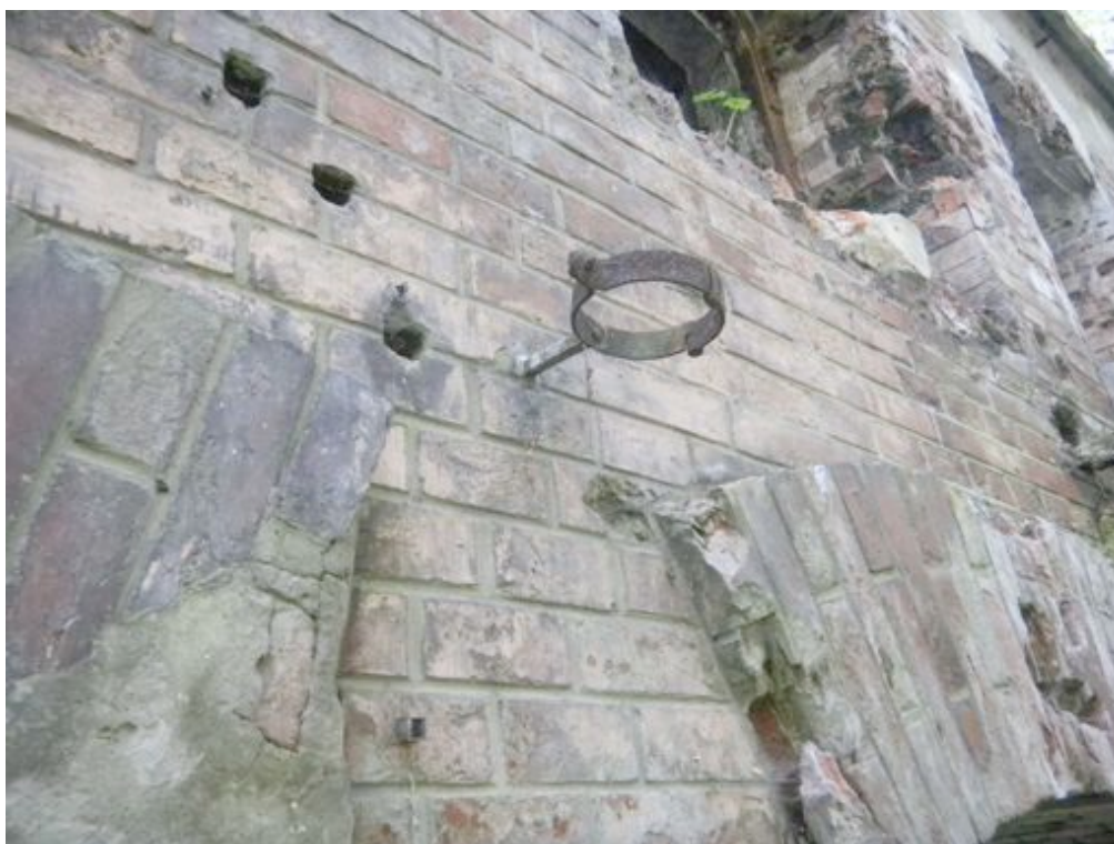
Fot. 48. Wtórne łąty cementowe, wykruszenia i ubytki w wążku ceglanym.
