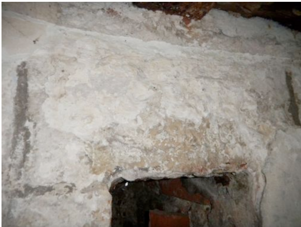
Fot. 27. Bloki kamienne pokryte powłokami malarskimi, widoczne wtórne spoiny cementowe.
