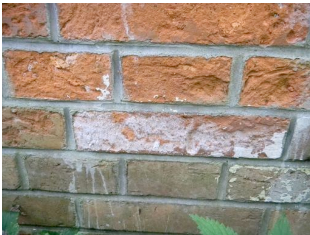
Fot. 22. Wykwity soli rozpuszczalnych w wodzie z cementu, który użyto do spoinowania ściany – widoczne rozwarstwienia powierzchni cegieł.
