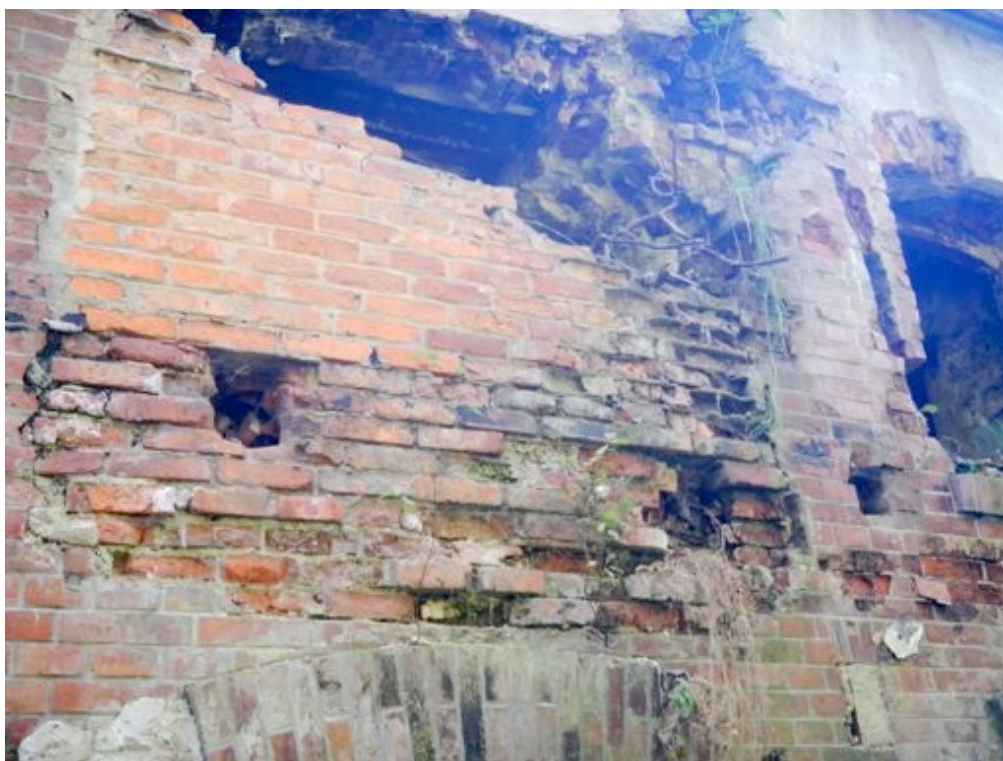
Fot. 16. Wtórne zamurowanie otworu okiennego na piętrze – widoczna znaczna destrukcja filara międzyokiennego.
