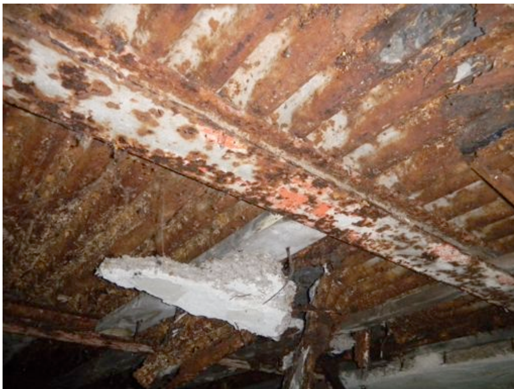
Fot. 23. Konstrukcja stropu nad parterem –widoczna znaczna korozja stali, zarówno belek jak i blachy falistej, która doprowadziła do znacznych ubytków.
