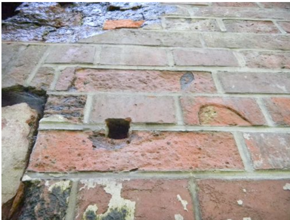
Fot. 15. Rozwarstwienia lica ceglanego, spowodowane wypełnieniem spoin szczelną zaprawą cementową.
