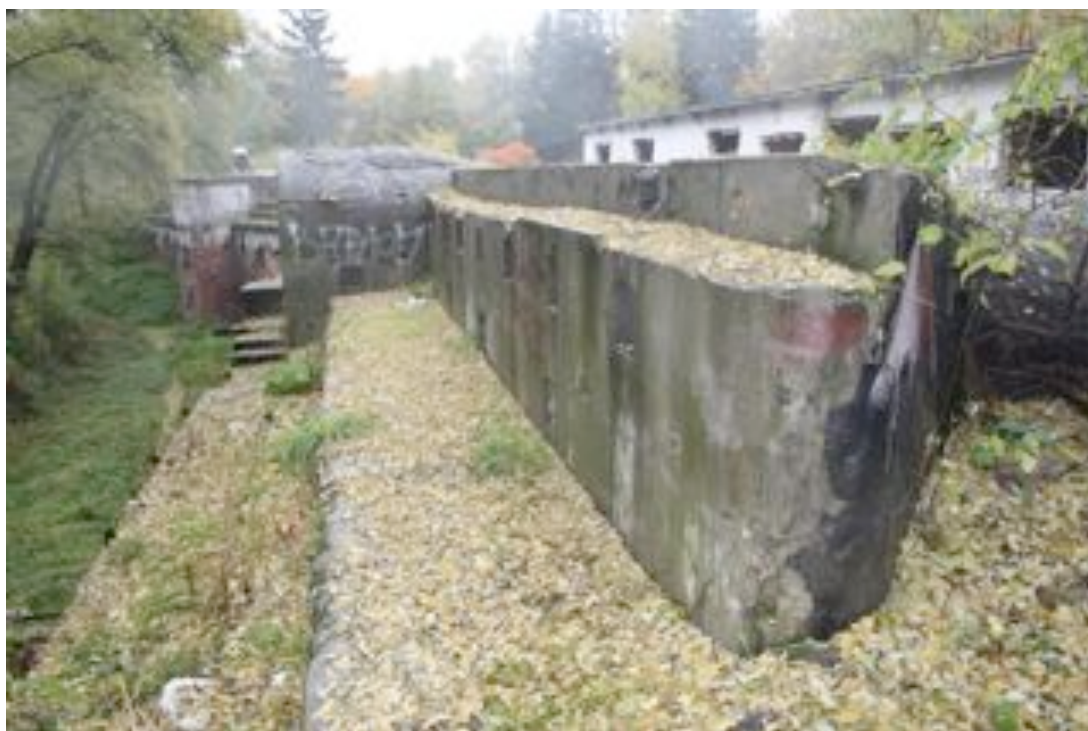
Fot. 5. Galeria betonowa – widoczne spękania i ubytki zewnętrznej warstwy betonu, silny rozwój mikroorganizmów.
