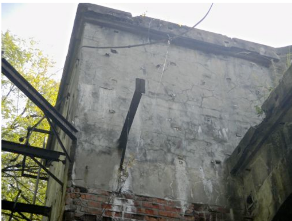
Fot. 18. Spękania i odspojenia wypraw tynkarskich na wieży, widoczna zachowana konstrukcja stalowa galerii.
