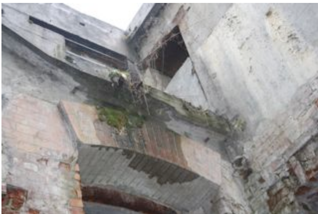
Fot. 5. Galeria betonowa – widoczne spękania i ubytki zewnętrznej warstwy betonu, silny rozwój mikroorganizmów.
