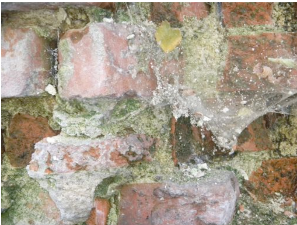
Fot. 64. Skupiska drobnoustrojów w miejscach zaprawy murarskiej.
