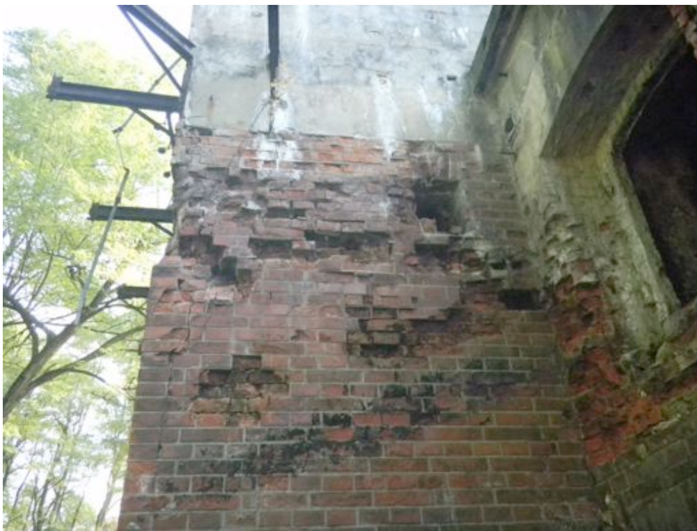
Fot. 13. Znaczne rozwarstwienia lica ceglanego wieży – widoczne spękanie pionowe narożnika.
