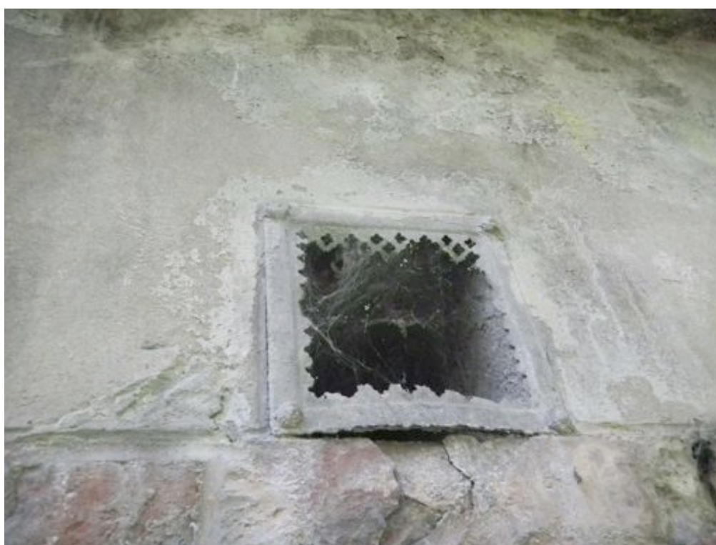
Fot. 58. Pozostałości pierwotnej ażurowej kratki wentylacyjnej.
